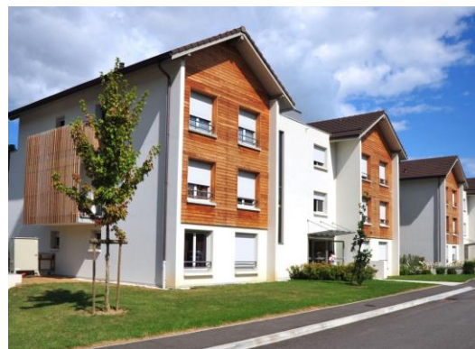
© Patriarches _ logements à Grésy sur Aix (73)
