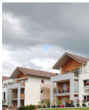
© Patriarches _ logements à Grésy sur Aix (73)
