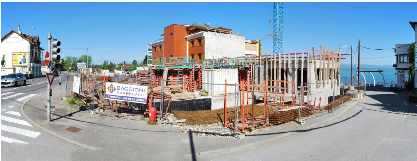
6 – Vue sur la construction de nouveaux logements à l'angle de la rue de la plage et de la RD 1005. Le rue de la place débouche à droite du cliché sur le lac. On distingue l'hôtel restaurant l'amiral à droite et la RD 1005 à gauche.
