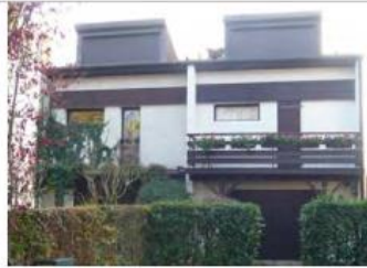
Linteaux recouverts de planches de bois peint teinte brun-foncé
