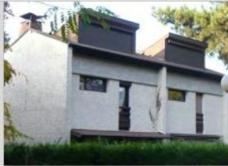
Linteaux béton brut
