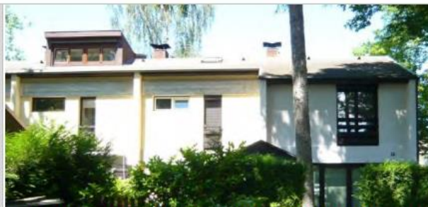
Les fenêtres de toit sont limitées en nombre à 1 fenêtre par pan de toit et placées au plus près de la panne faîtière. Dimension maximale de 1 m 2 .
