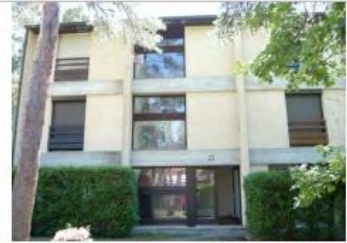
Maintien des linteaux en béton brut pour marquer les niveaux
