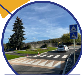
Sécurisation carrefour du cimetière
