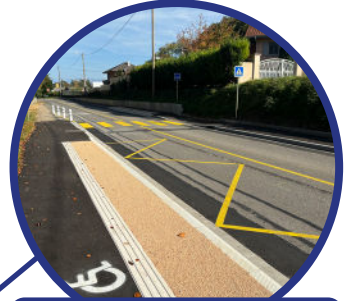
Sécurisation Senaillet rue du Chablais
