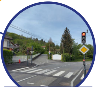
Sécurisation carrefour du Martelin
