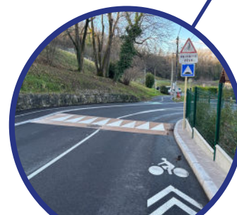
Sécurisation virage de Crochet, rue de Publier
