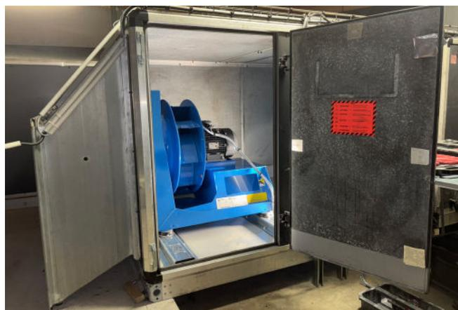
Un des nouveaux ventilateurs installé dans une CTA (centrale de traitement d'air) du bassin sportif
